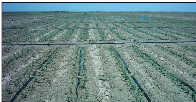
پهن کردن لوله های تیپ
