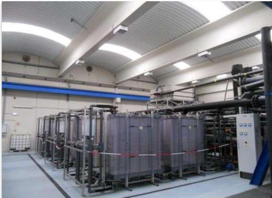
شکل ۲ - تجهیزات الکترودیالیز نصب شده در تصفیه خانه شهر بارسلونا
